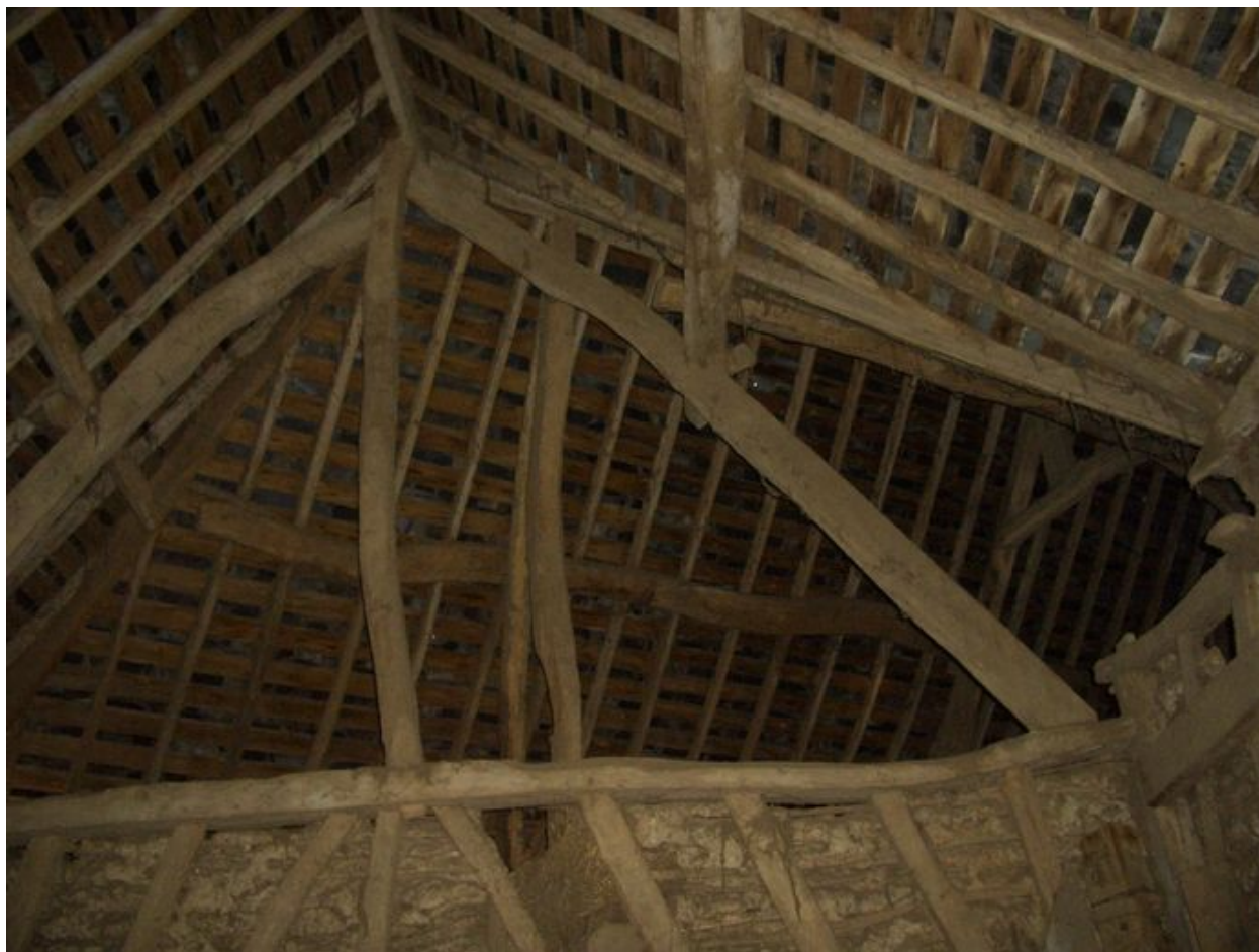
Vue de la charpente au niveau de l'angle formé par les deux granges.
