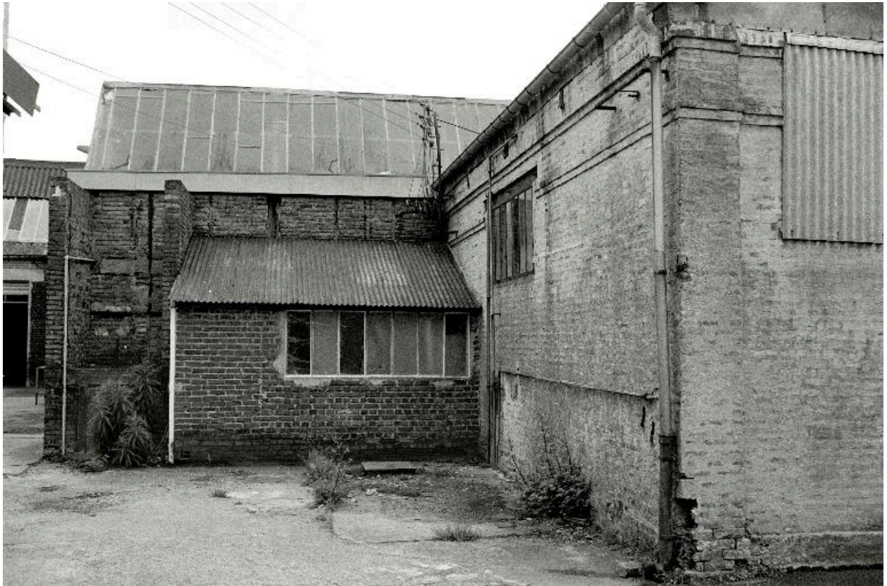
Atelier de fabrication, vue partielle, en 1990.
