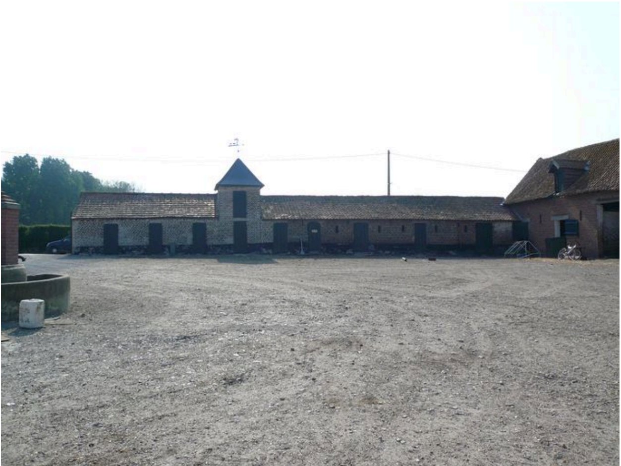
Vue des étables à cochons à l'ouest de la cour.
