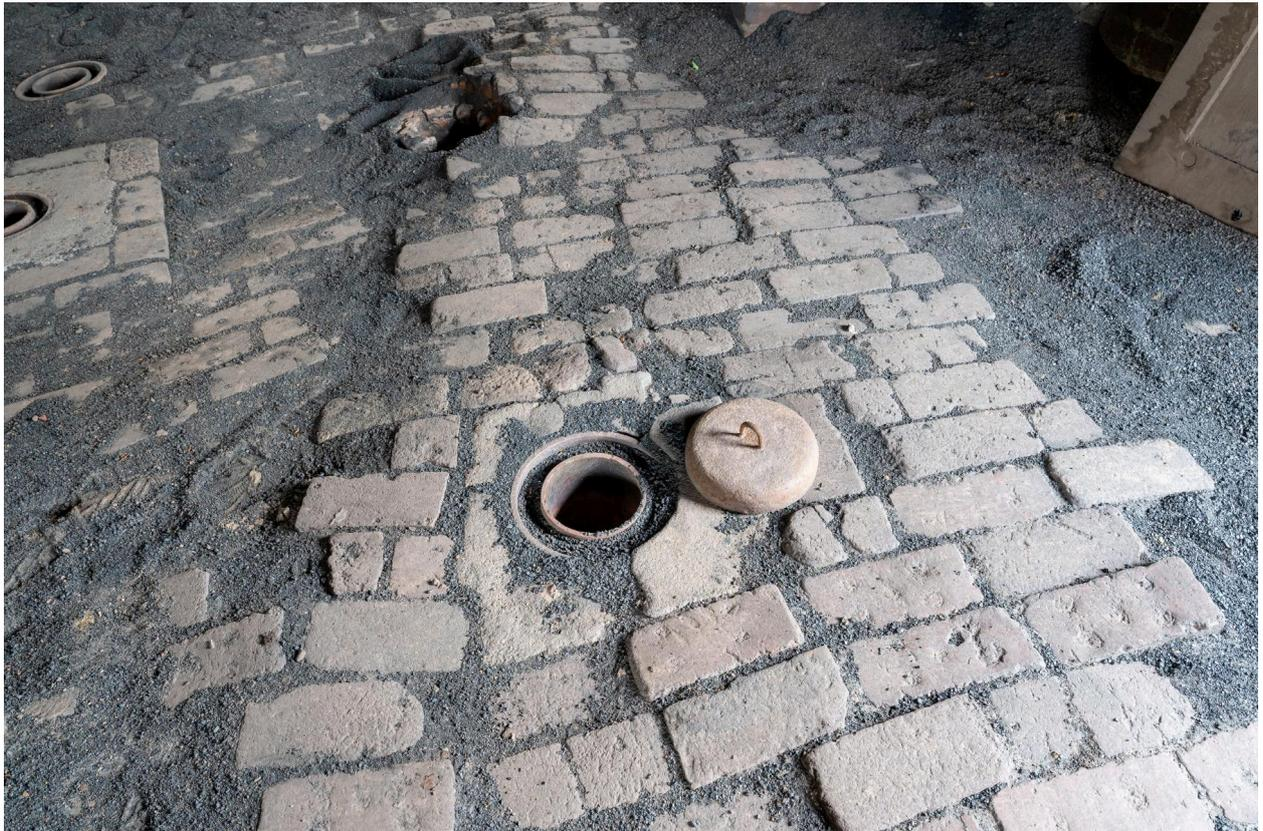
Couvrement du four Hoffmann. Au sol une trappe d'alimentation en poudre de charbon en position ouverte.
