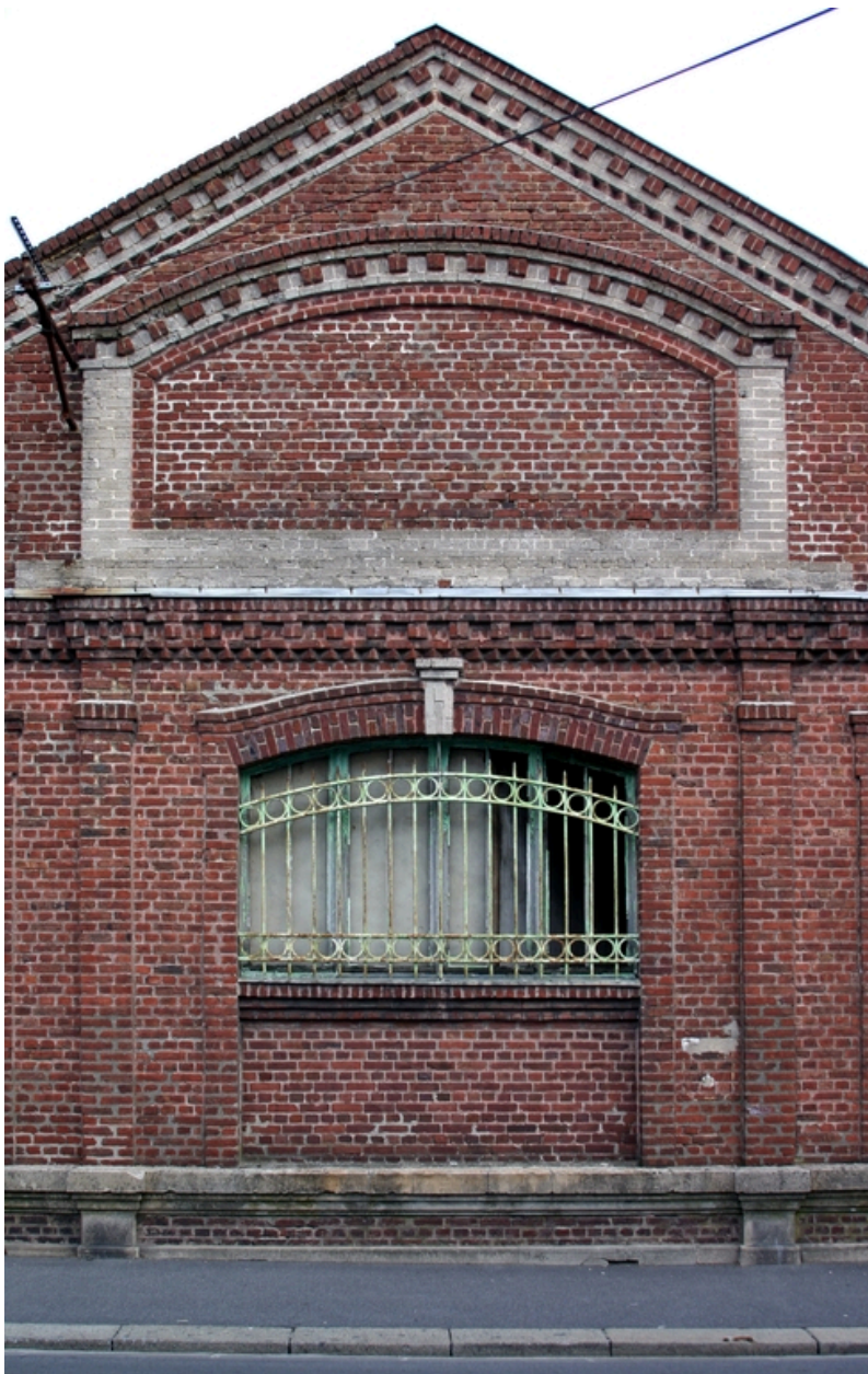
Magasins reconstruits en 1919-1920 : détail du pignon.
