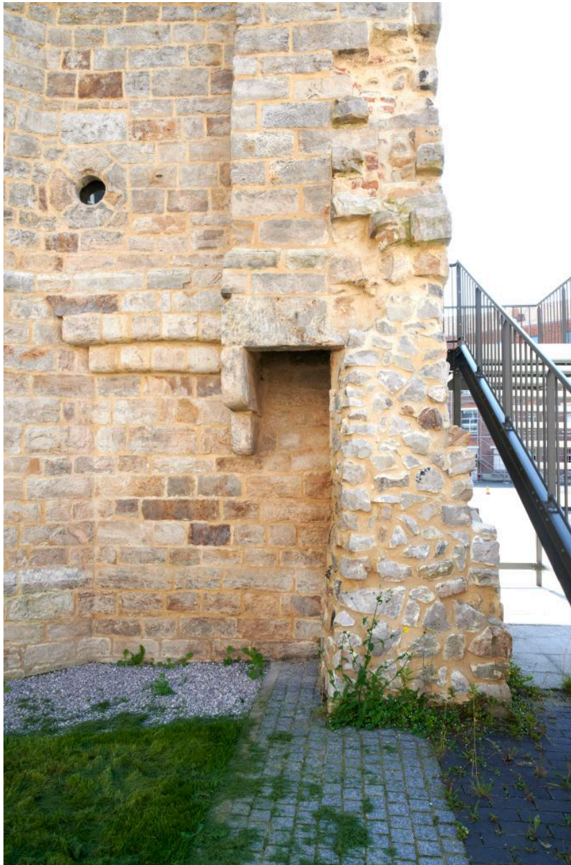
Vue en détail de la sortie extérieure des latrines sur la face est.
