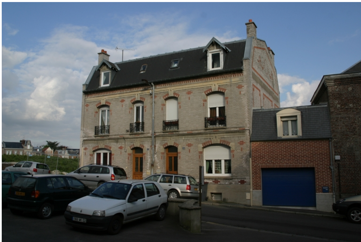
Façade antérieure des logements d'employés.
