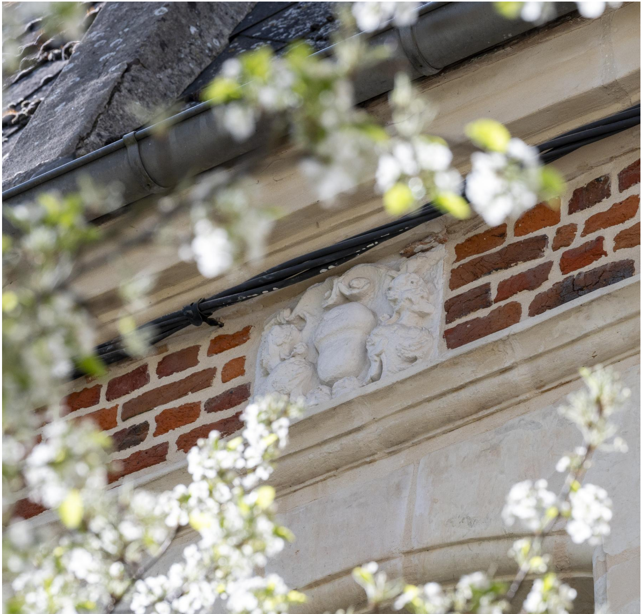
Détail des masques de personnages masculins adossés autour d'un écusson situé dans la partie gauche du bandeau d'attique.
