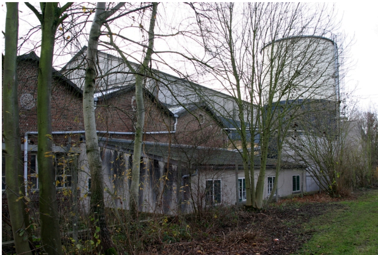
Ateliers et silo vus depuis le canal de Saint-Quentin.
