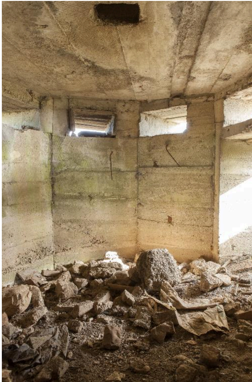
Vue intérieure, vers le nord
