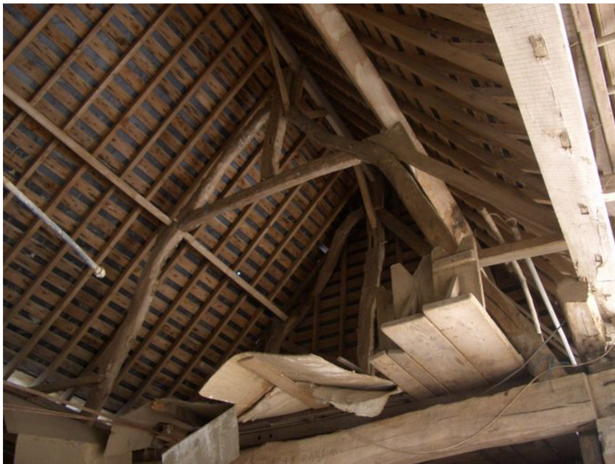
Vue détaillée d'une ferme de cette grange.
