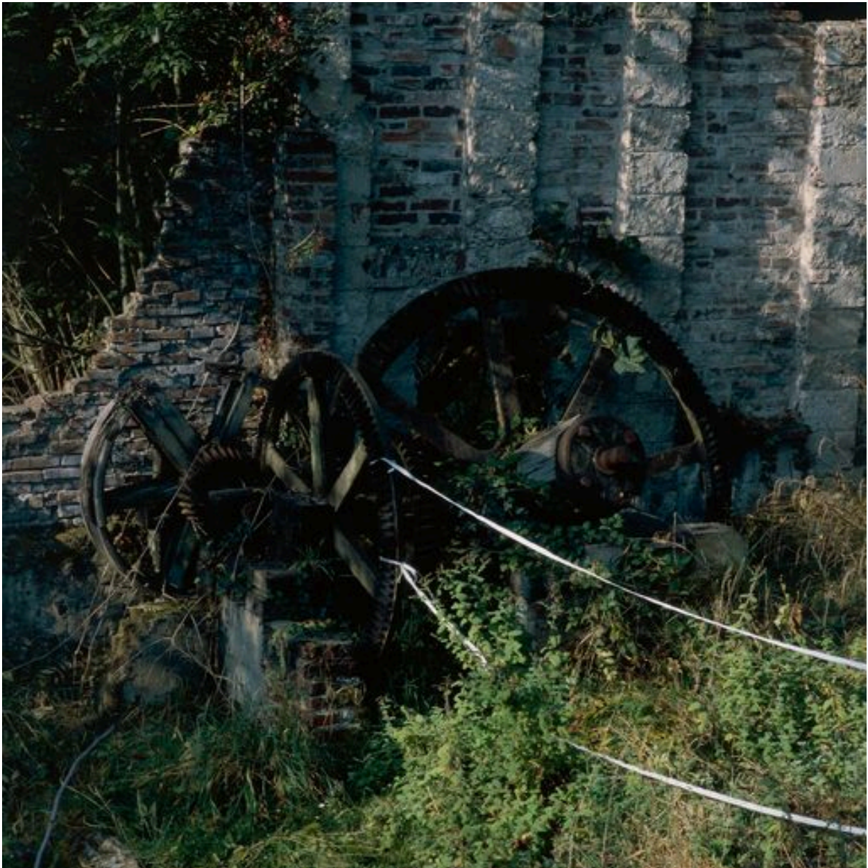
Les vestiges des engrenages de transmission.
