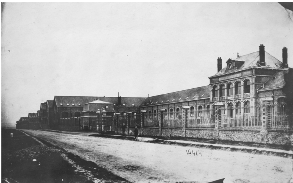
L'usine Daltroff vue depuis la rue de Guise, avant 1914 (AD Aisne).
