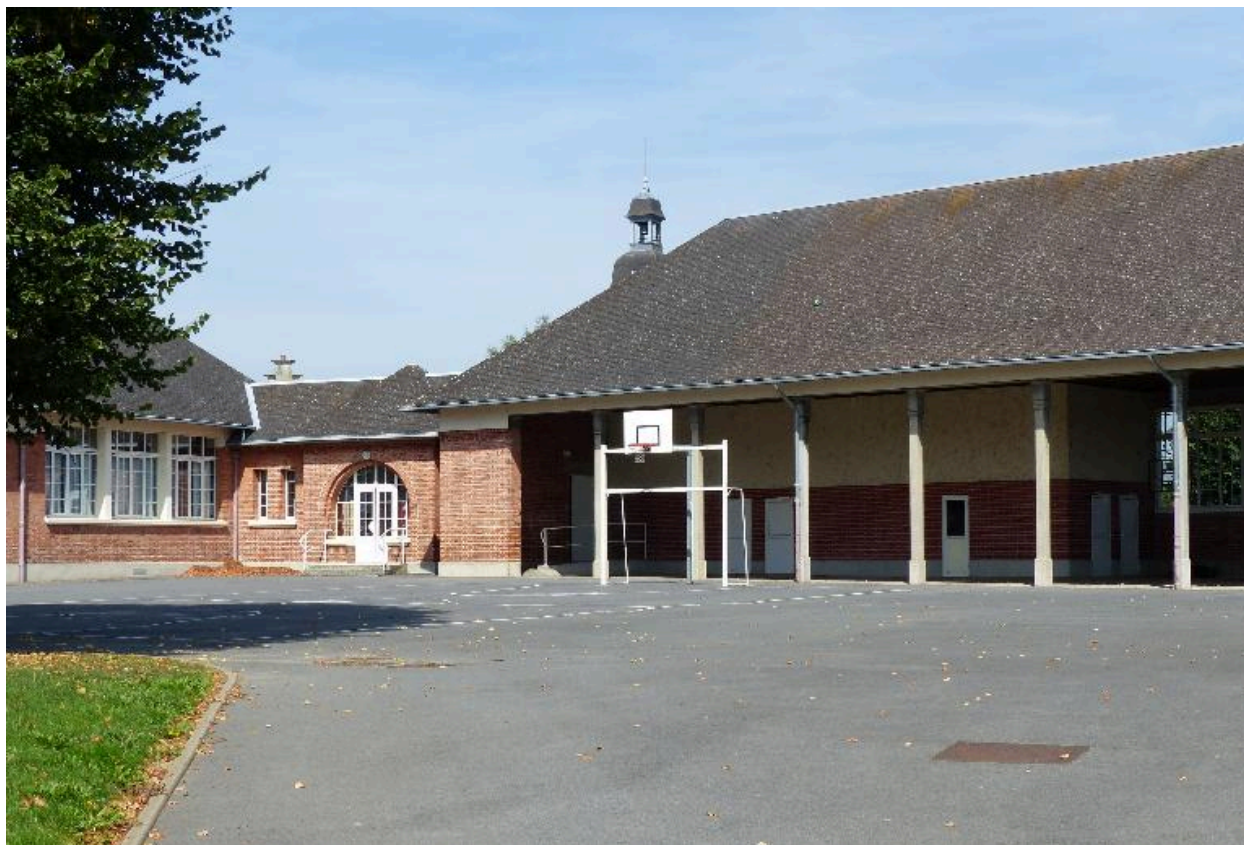
La cour et le préau de l'ancienne école de garçons, vus depuis le sud.
