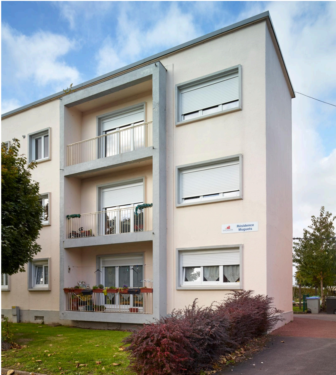
Vue du bloc A côté rue.
