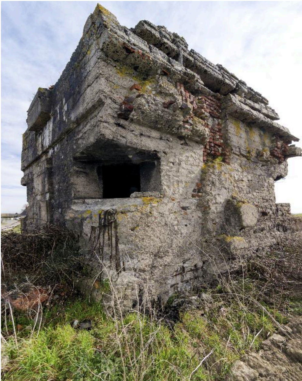
Embrasure de tir situé sur l'angle nord-ouest de l'édifice.
