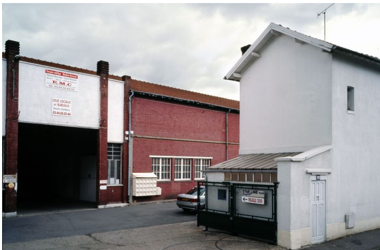
Entrée des ateliers de fabrication.
