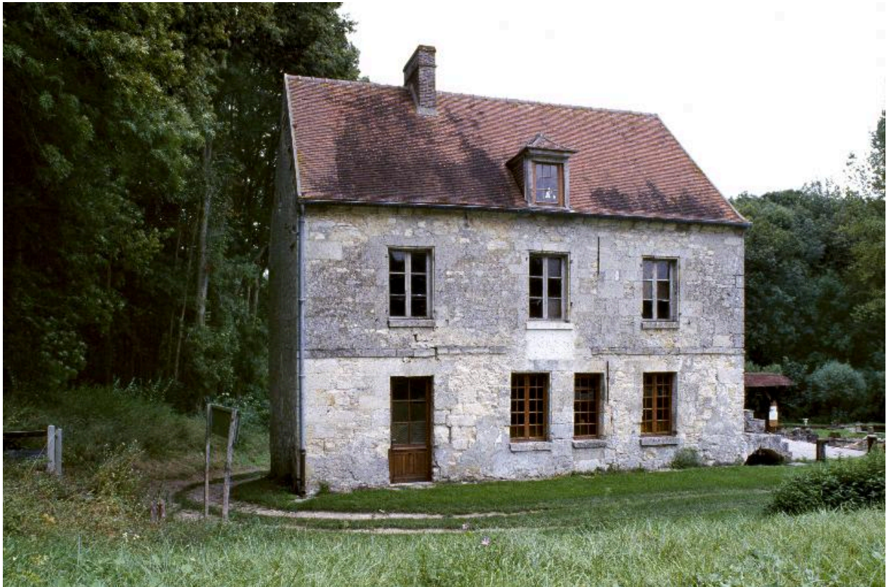
Vue de l'élévation occidentale du moulin.
