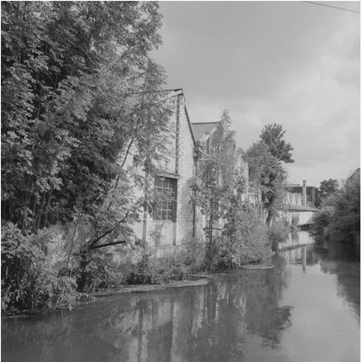
Atelier de fabrication, flanc sud-est.
