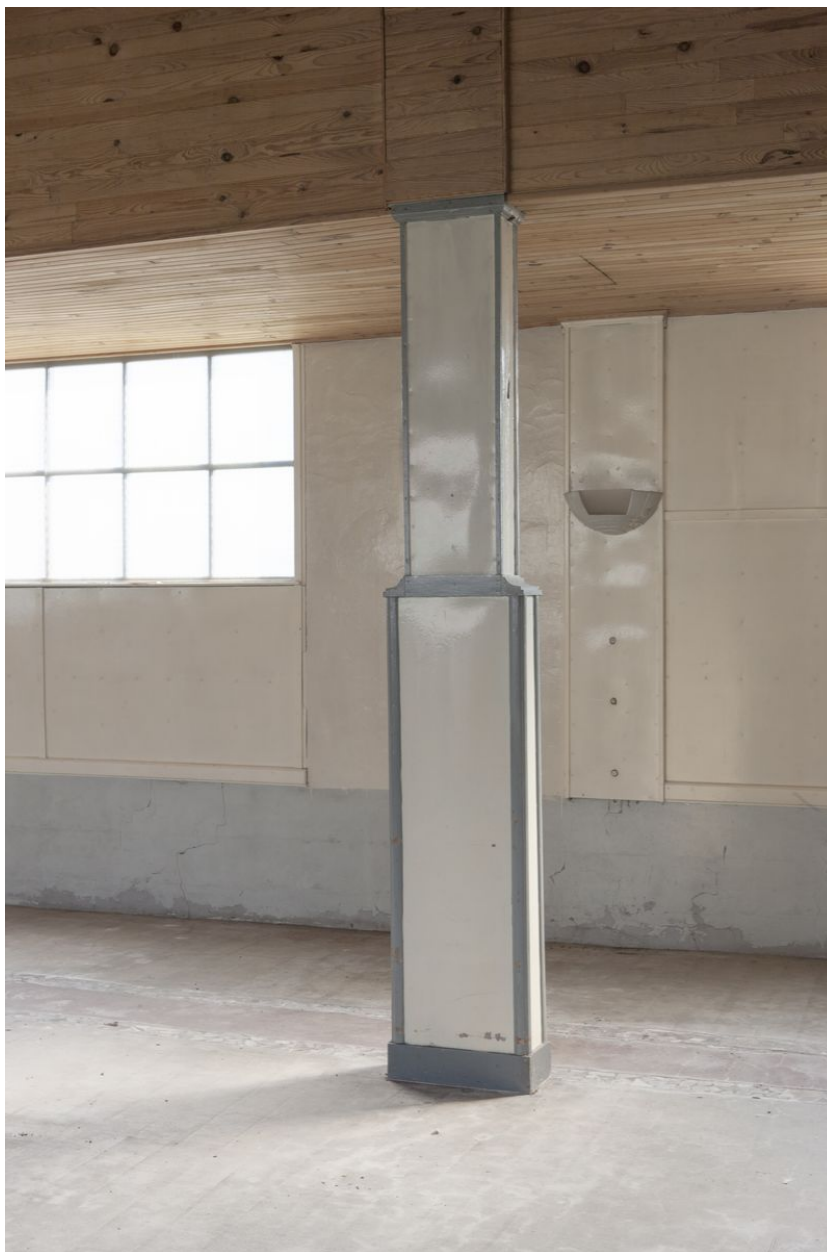
Vue générale d'un pilier de la nef.
