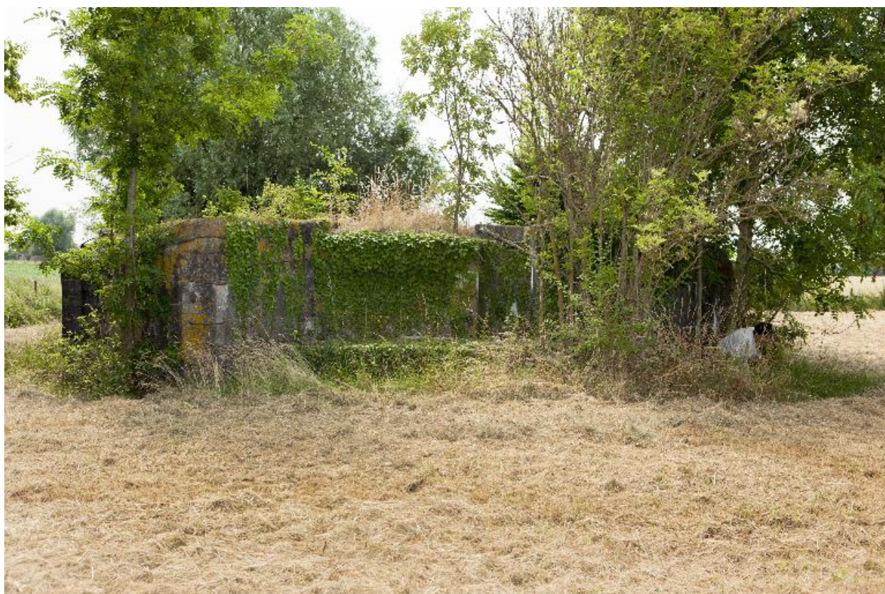
Vue générale, vers le sud-ouest
