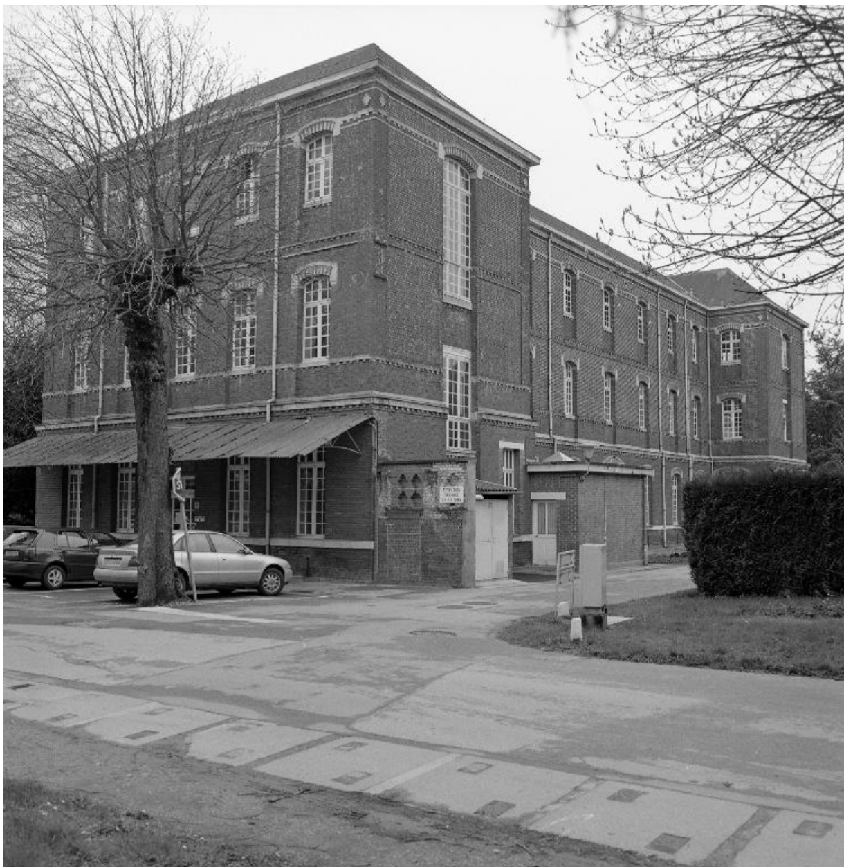
Bâtiment d'hospitalisation dit pavillon 9, élévations postérieure et latérale droite, vue d'ensemble.
