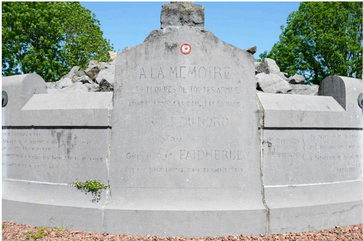
Vue de détail du panneau central avant.
