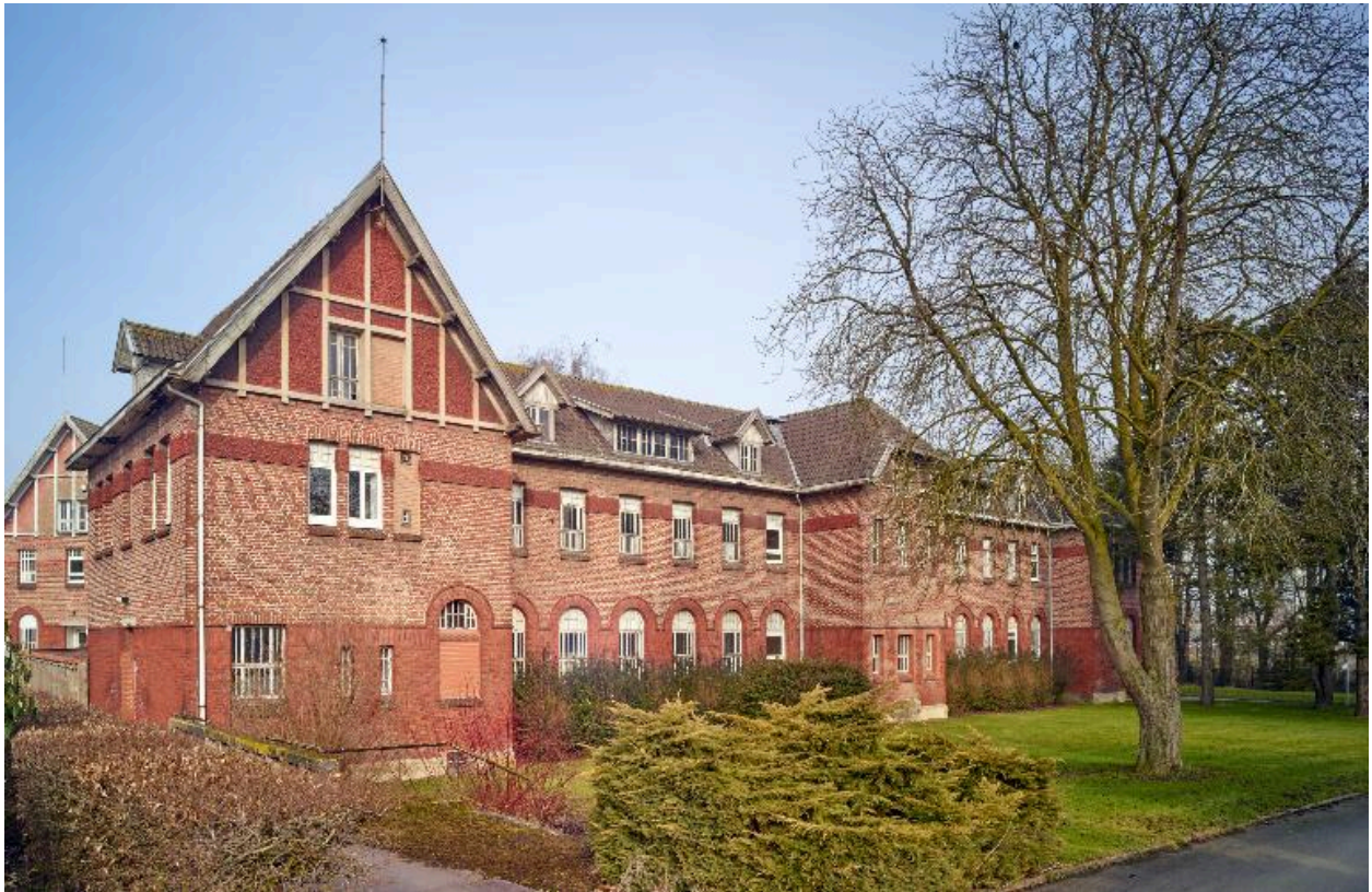
Bâtiment d'hospitalisation dit pavillon G9, élévation antérieure, vue générale prise de trois quarts gauche.
