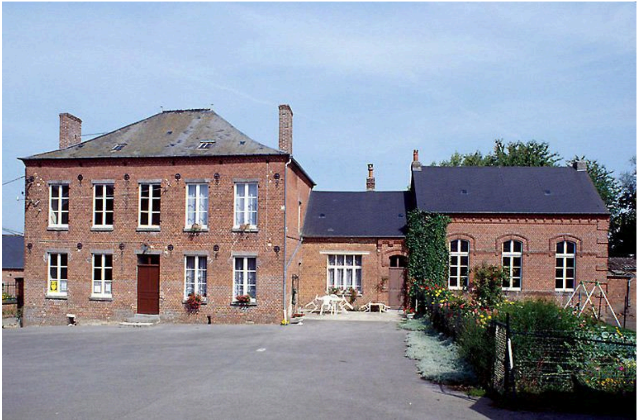
Vue d'ensemble des bâtiments : sur la gauche la mairie, sur la droite le logement de l'instituteur et la salle de classe.
