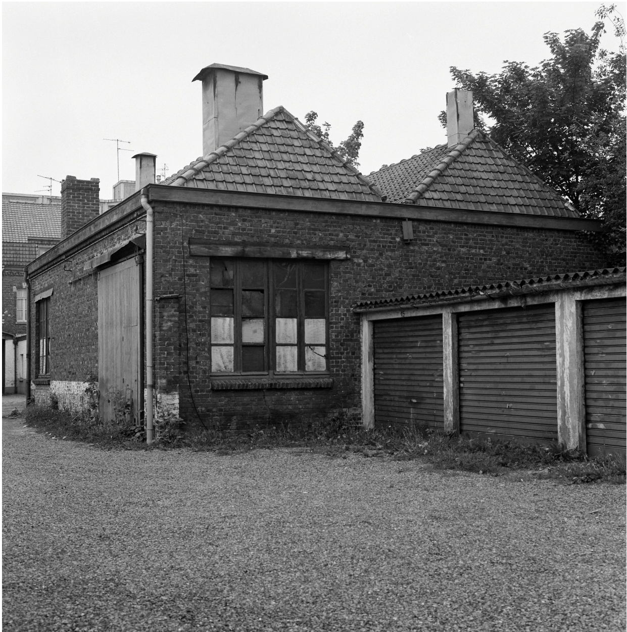
Atelier de fabrication (?). Vue prise vers l'ouest.
