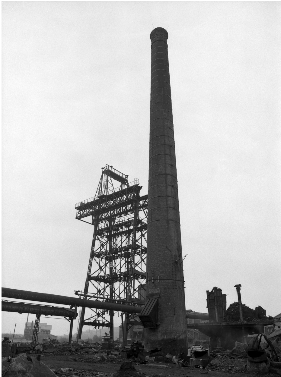
Cheminée d'usine, vue générale.
