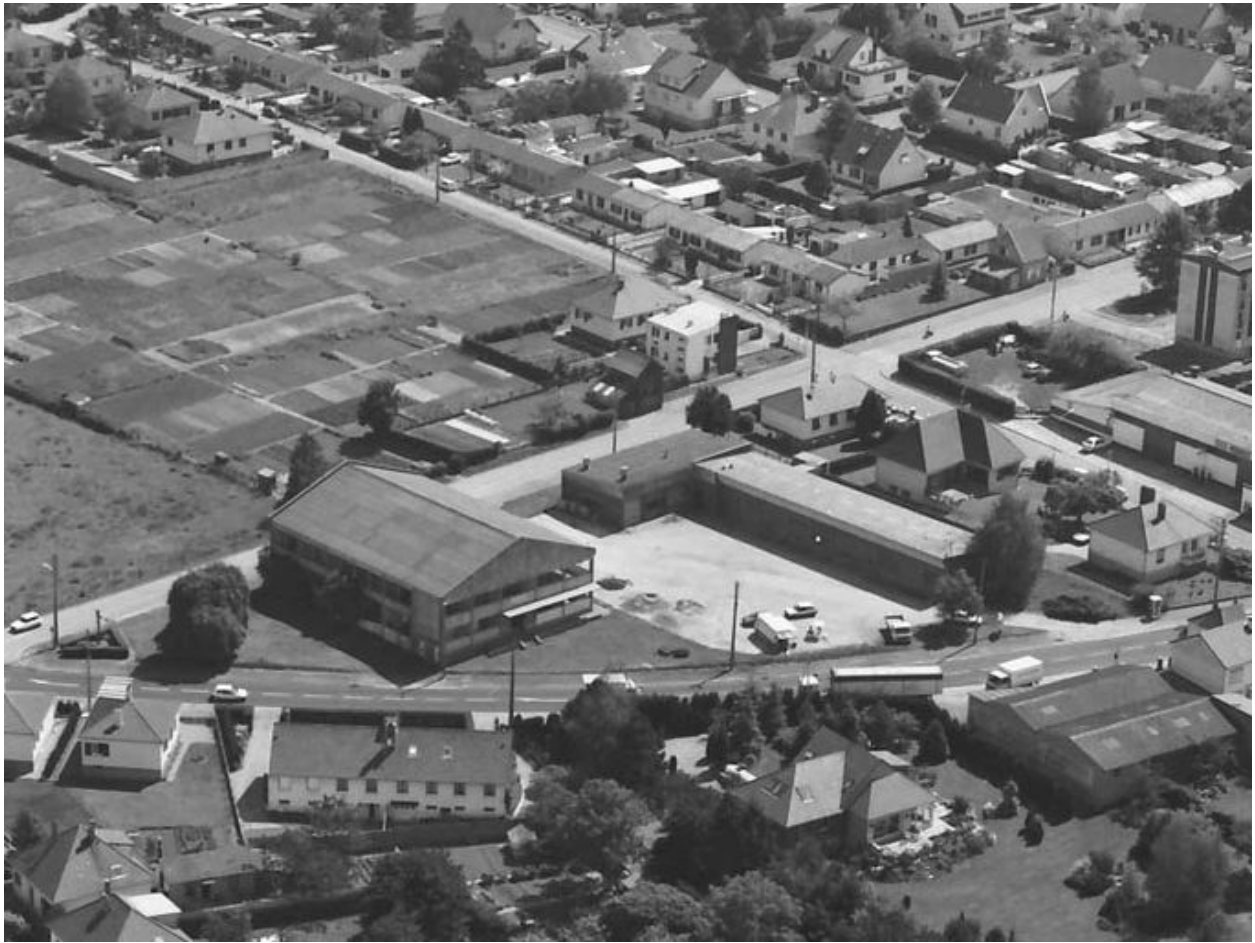
Vue aérienne de l'usine en 1994.
