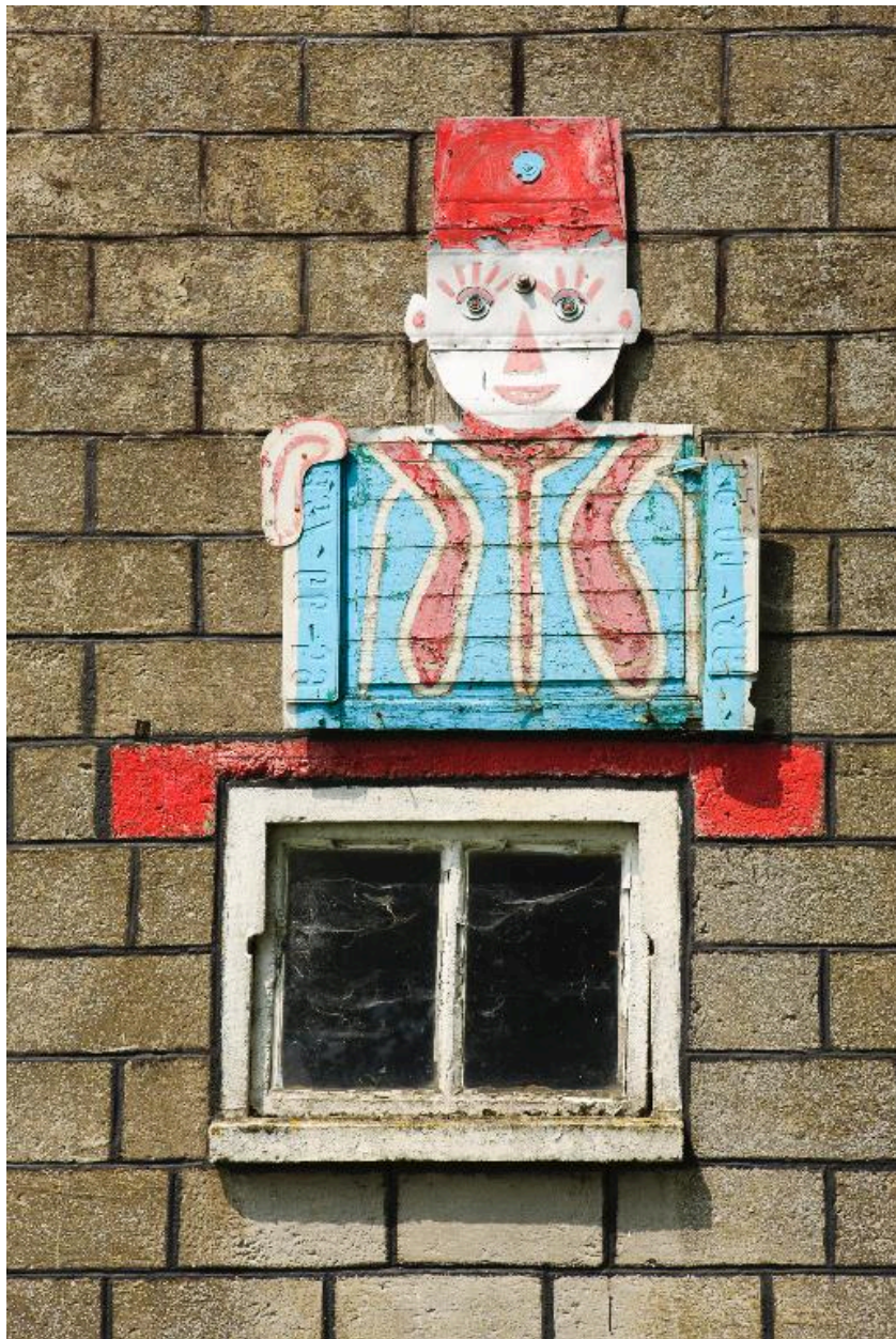
Pignon de l'ancienne porcherie : détail du tirailleur sénégalais.
