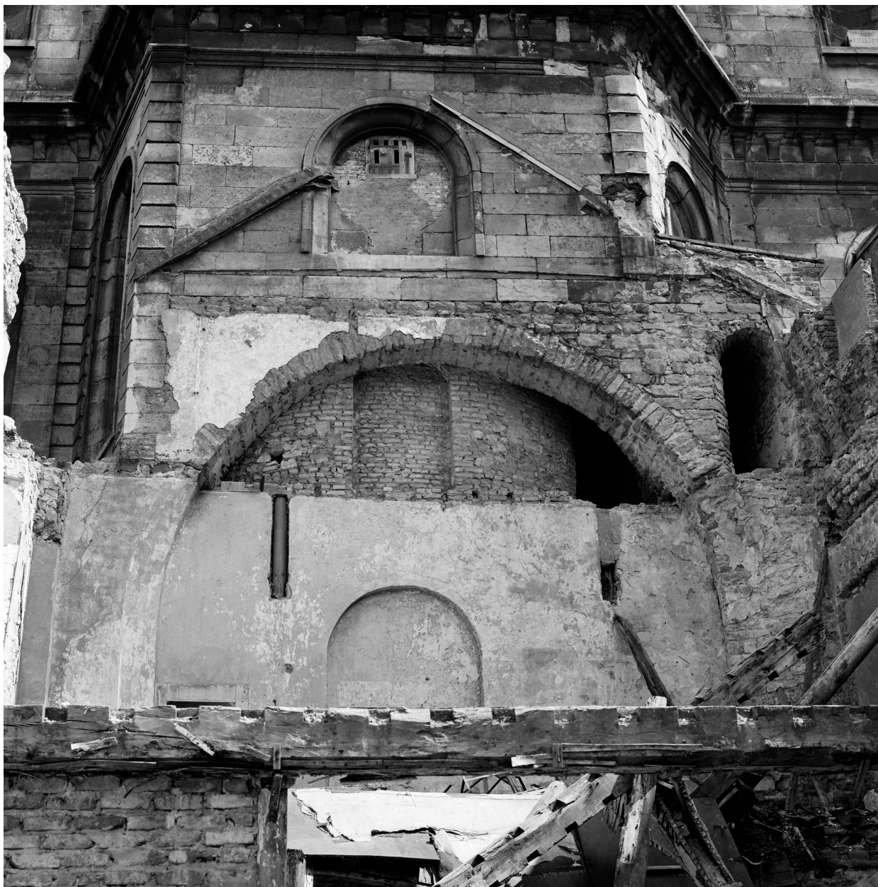
Bâtiment F, vue intérieure, jonction avec église.
