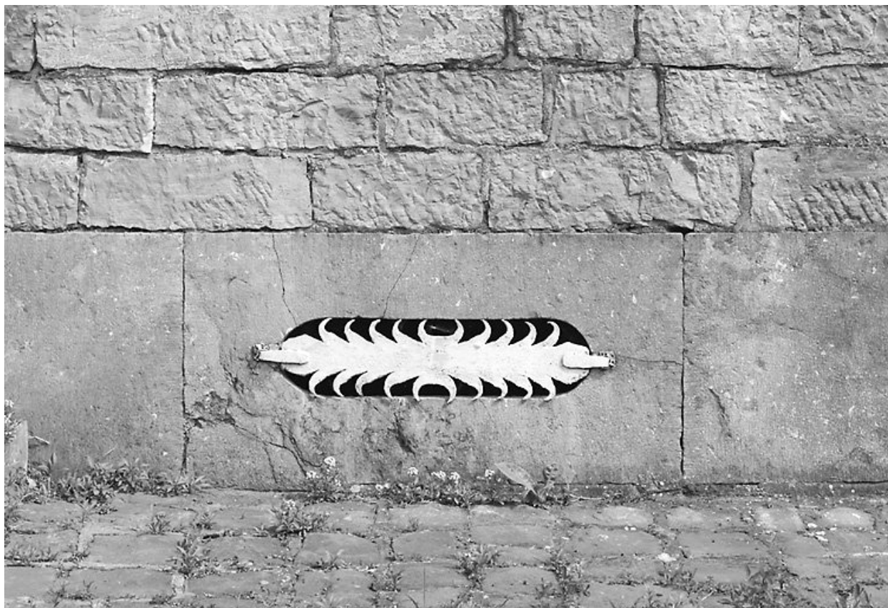
Détail d'un soupirail.
