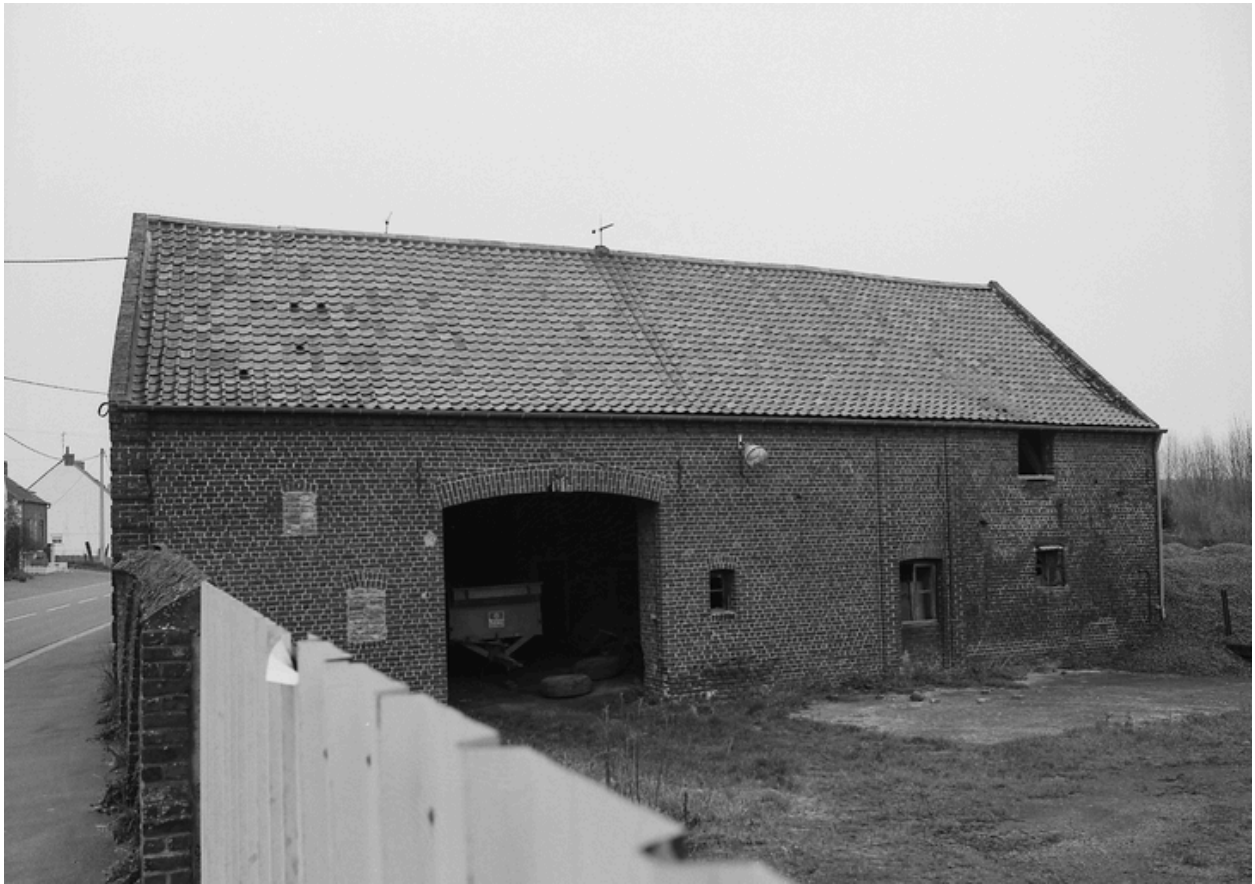
Vue générale de la grange située 869 Grand'Rue.
