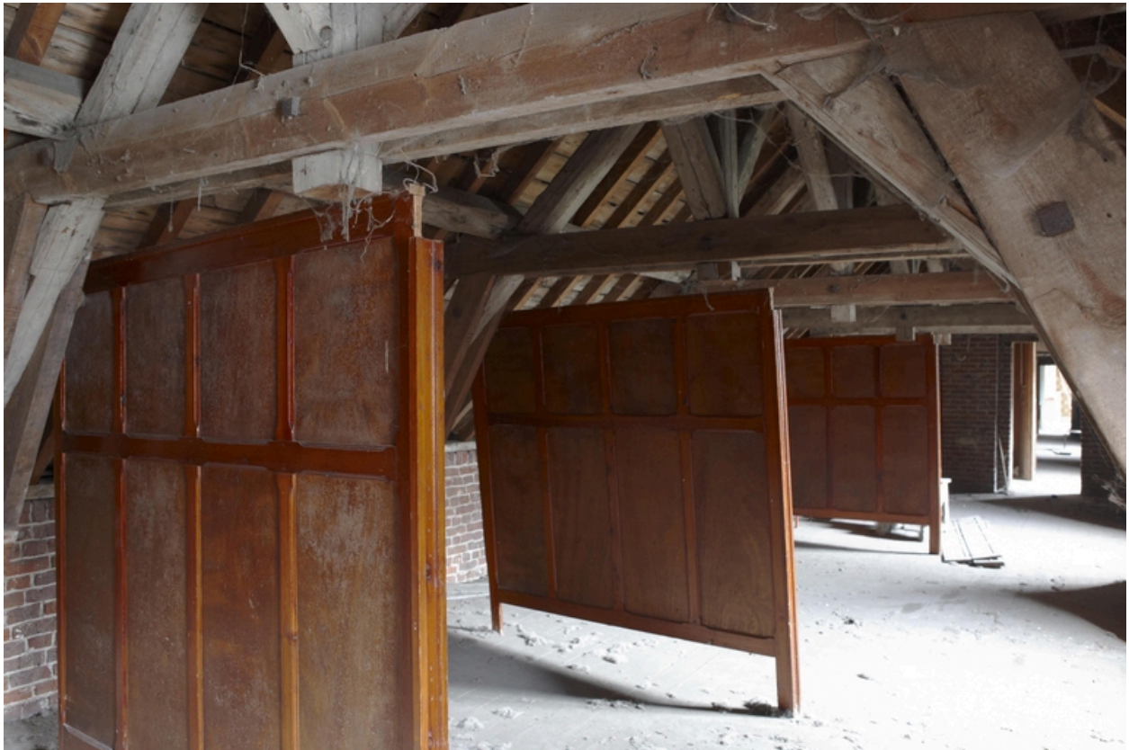
Les combles de l'aile sur rue.
