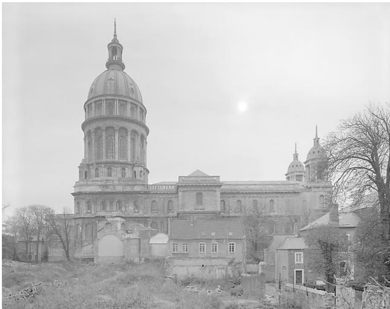
Basilique, façade nord, vue générale.
