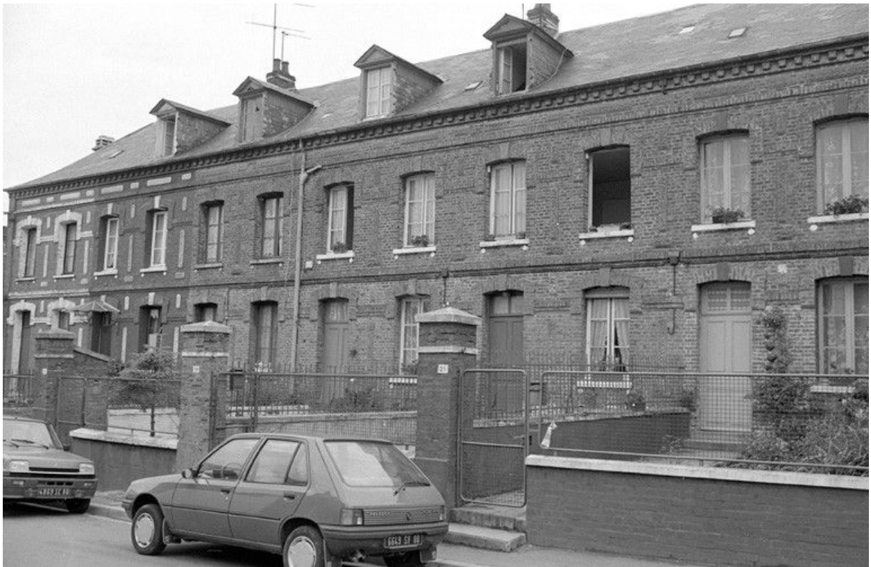
Logement d'ouvriers, élévation antérieure.
