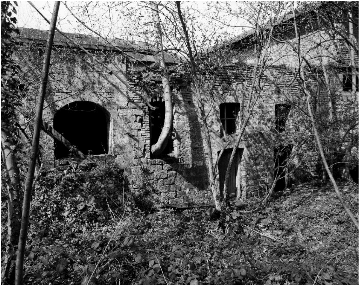
Atelier de fabrication, flanc est.
