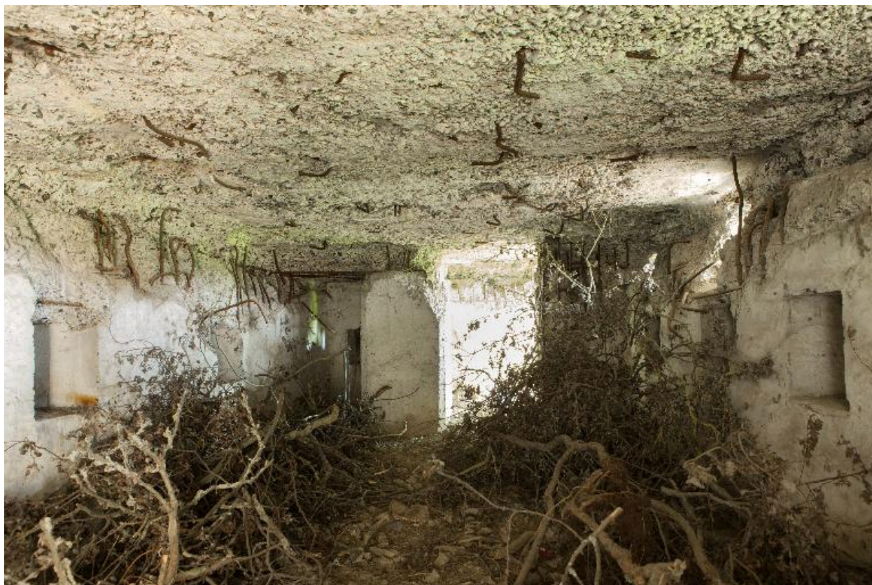
Vue intérieure, vers l'est
