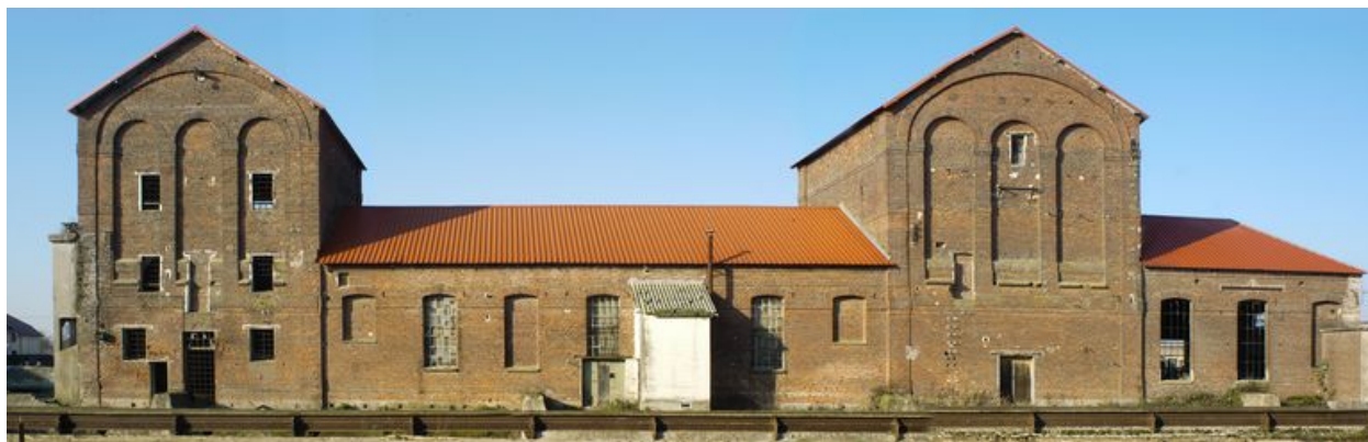
Façade postérieure (est) de la distillerie de 1880.
