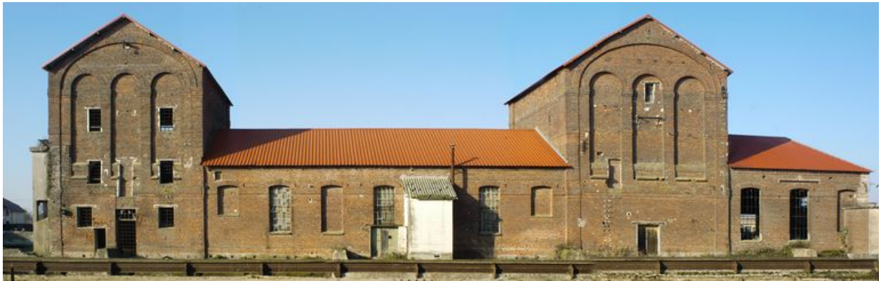
Façade postérieure (est) de la distillerie de 1880.
