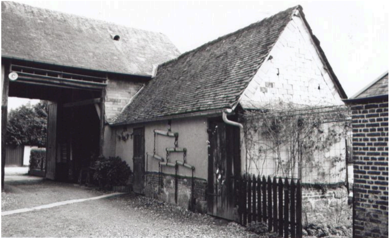
L'entrée charretière sous porche, façade sur cour.
