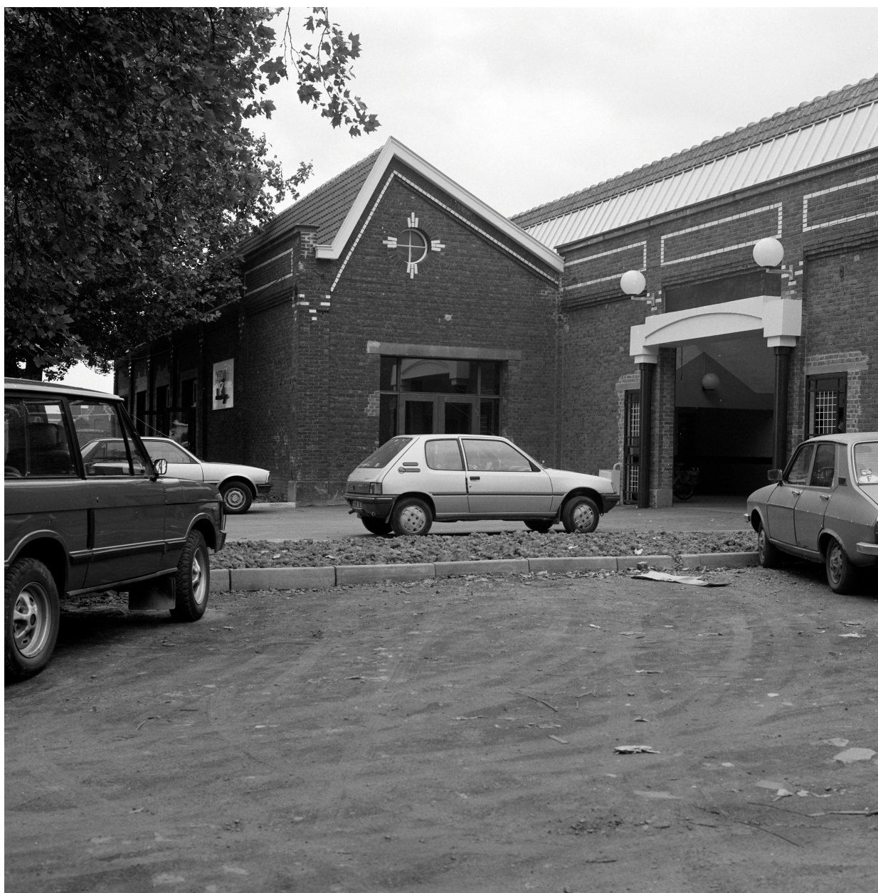
Ancien garage. Vue générale prise vers l'est.
