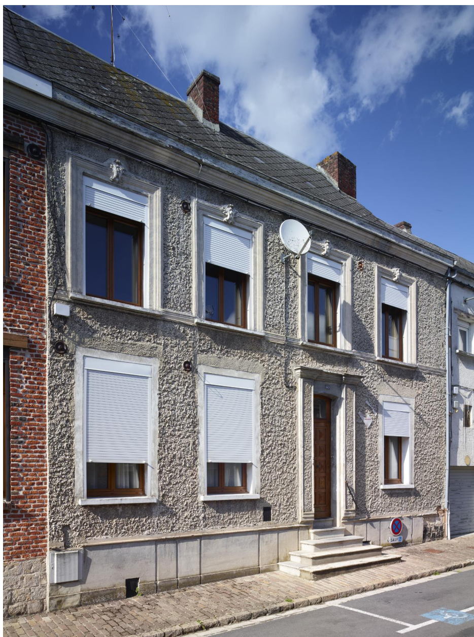
Maison, 40 rue Baillon : façade entièrement enduite en nid d'abeille.
