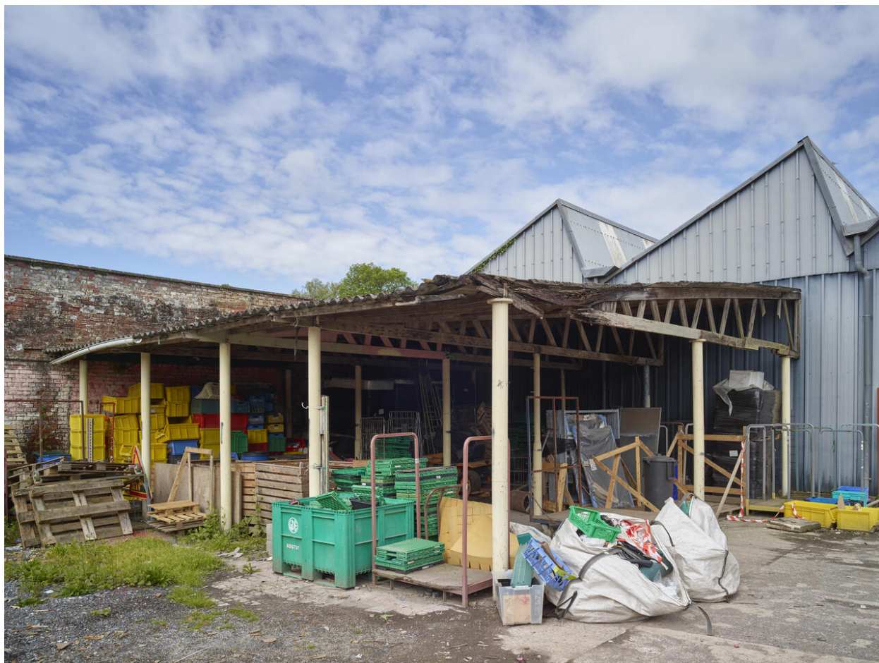
Pignons en sheds des anciens atelier d'encaissage, vue du côté nord.
