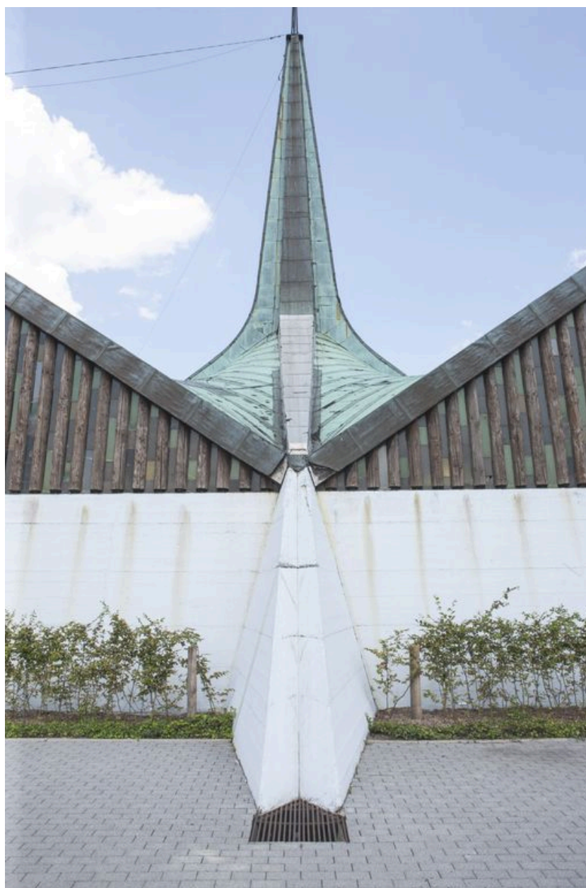
Vue axiale et rapprochée de l'élévation sud.
