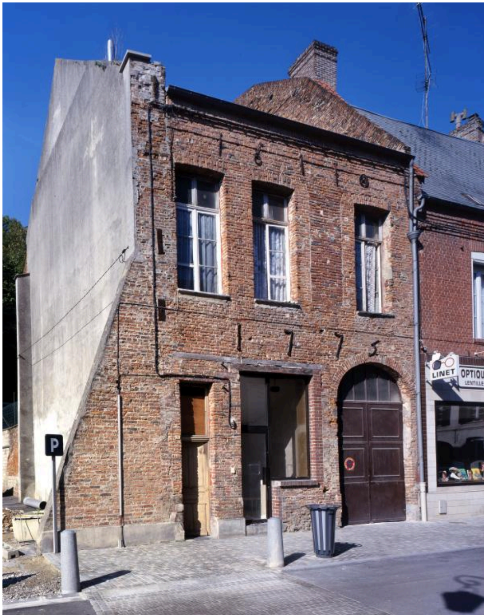
Vue de la façade sur rue.
