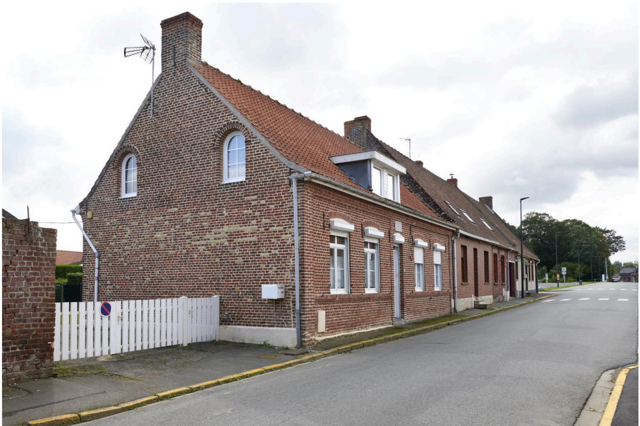
Façade et pignon est.
