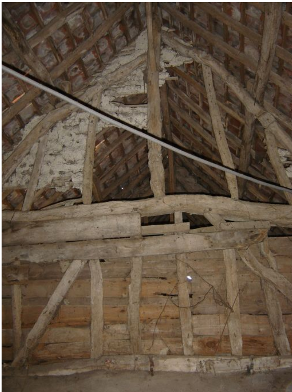
Détail de la charpente des bâtiments annexes.
