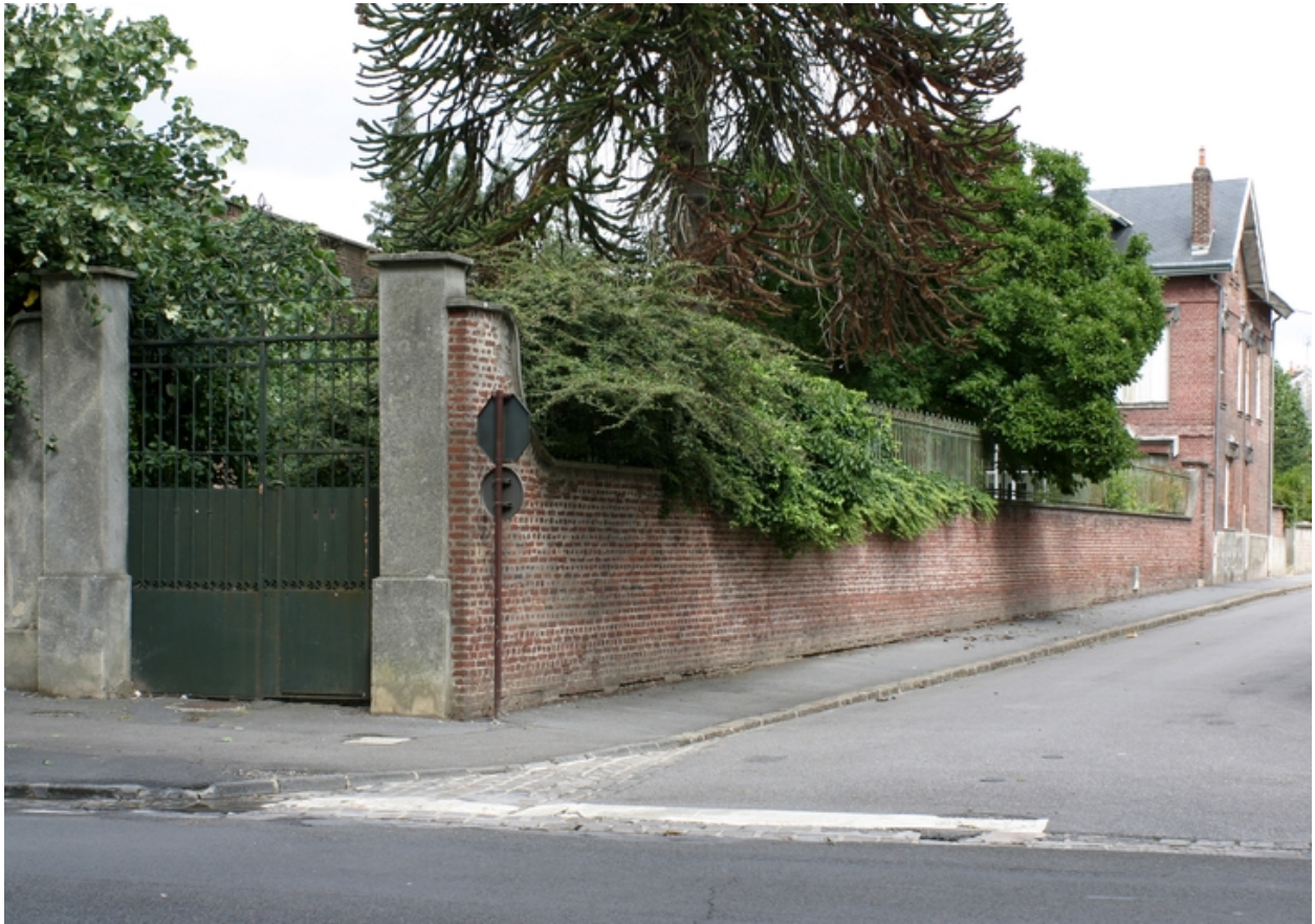
Logement patronal vu depuis le boulevard Gambetta.
