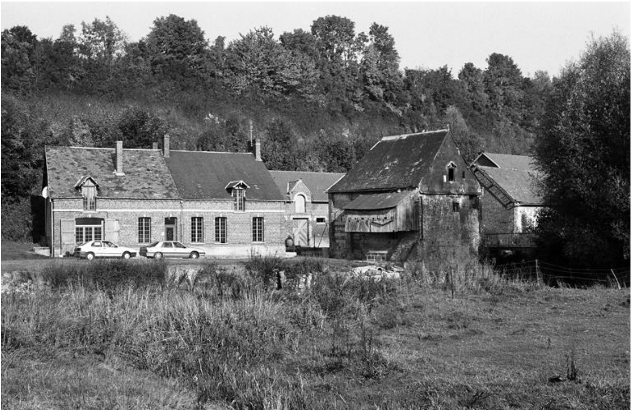
Vue d'ensemble des bâtiments, depuis le sud-est.
