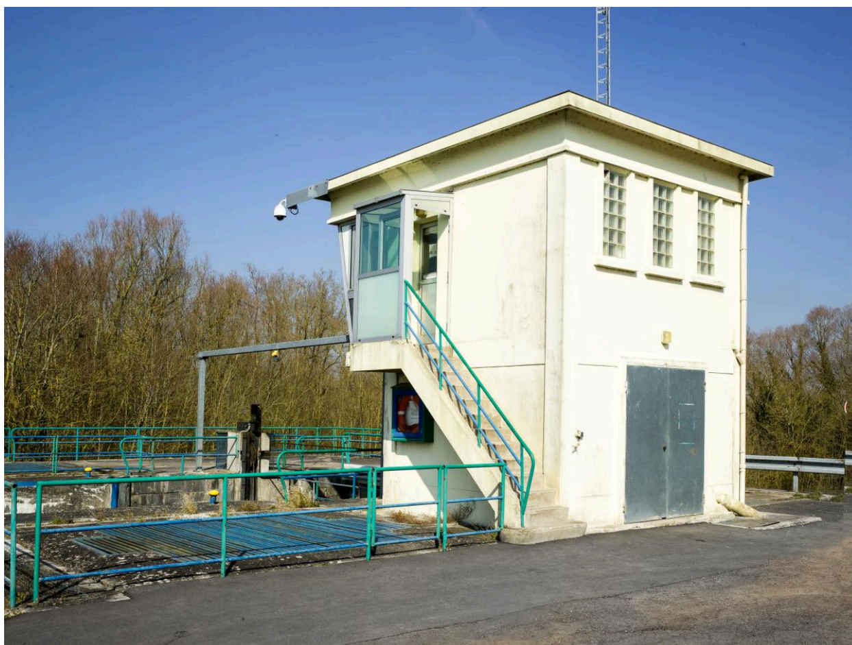
Poste de commande.
